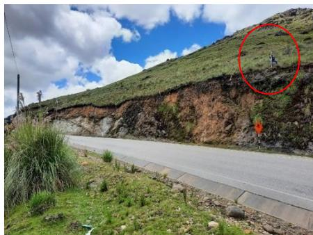
Figura 8: Punto de levantamiento topográfico en plataforma superior de talud.
