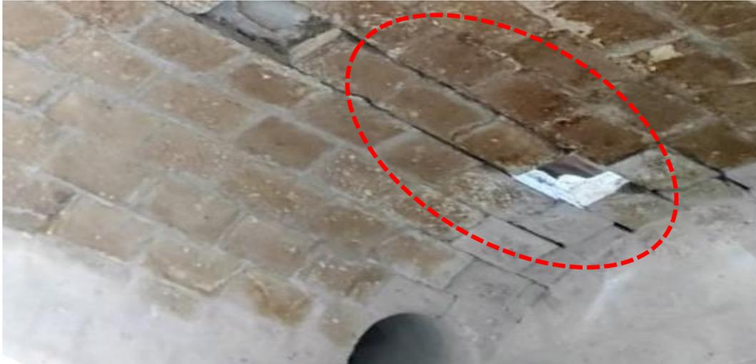
**Figura 20.** Deformación de bóveda y deficiente conexión con muros de casona
