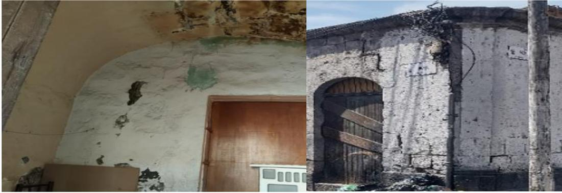
**Figura 17.** Muros de la casona C4 sin arriostramiento y conexión deficiente
