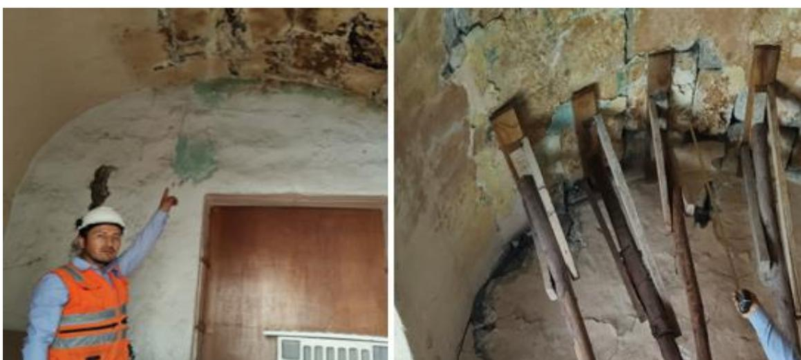
**Figura 23.** Inestabilidad de la cubierta (bóveda) de la casona C4
