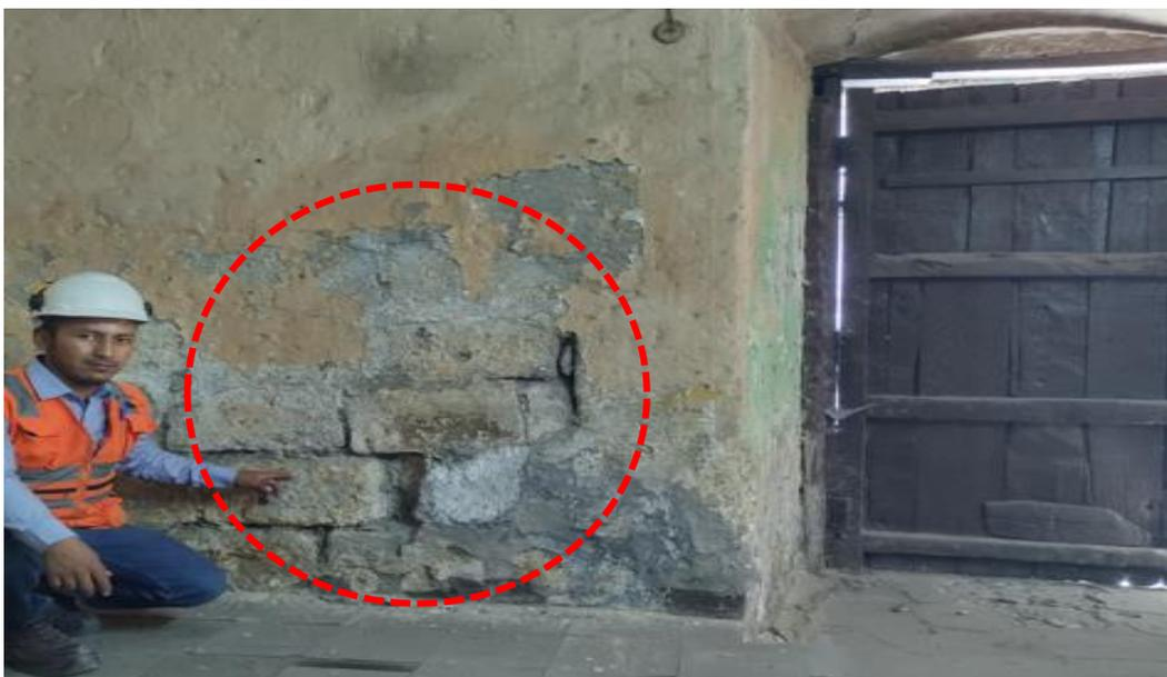
**Figura 19.** Desprendimiento de juntas de argamasa de la casona C4
