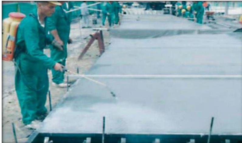
Figura 13. Curado de concreto
