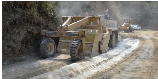
Figura 7. Estabilización del suelo arcilloso con cal.
