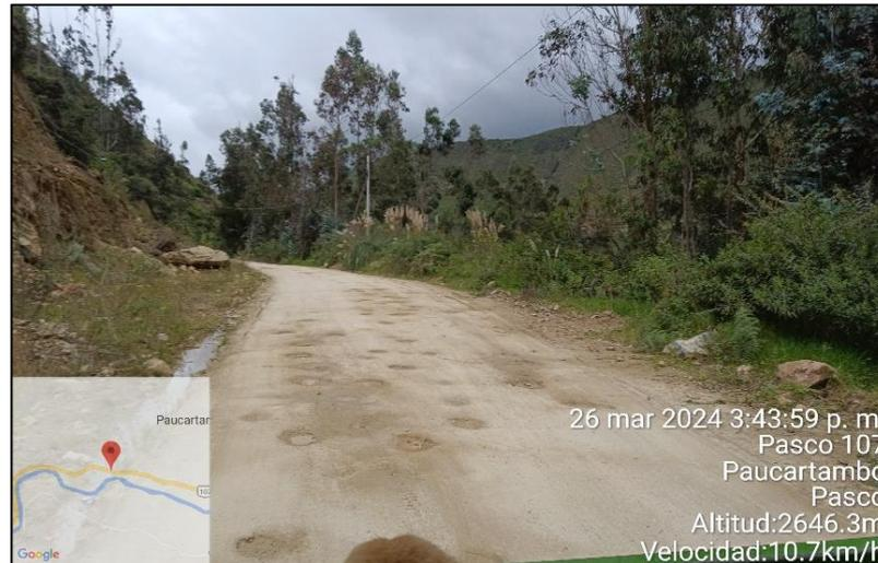
Figura 1. Suelo con deformaciones
