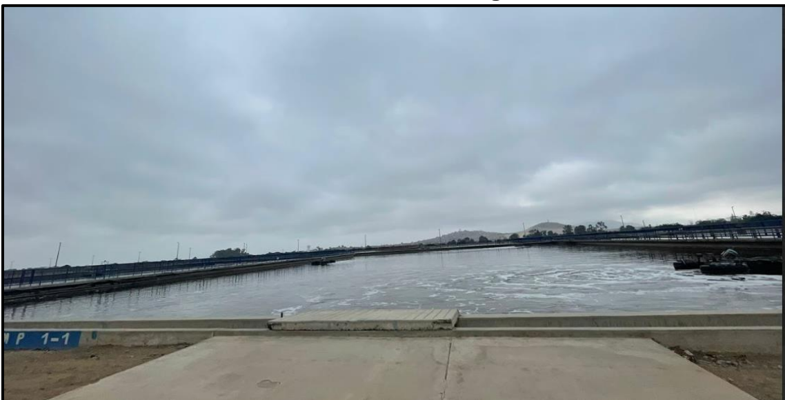
FIGURA 5. Características de las aguas residuales
