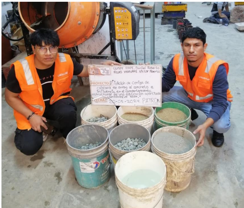
Foto 02: Dosificación para mezcla de concreto.
