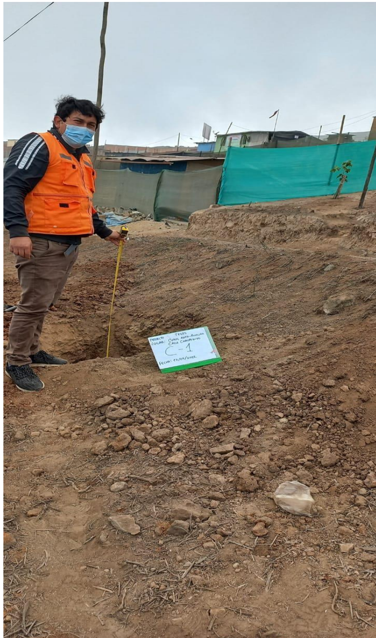
Figura N°5. Excavación de calicatas
