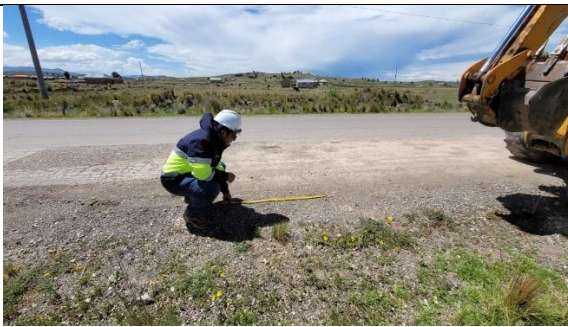
Figura 7. Medidas del ancho y largo para la extracción de calicatas. Elaboración propia.
