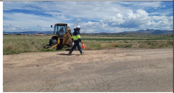
Figura 6. Colocando los conos de seguridad previniendo para posibles incidentes en zona de extracción de calicatas. Elaboración propia.
