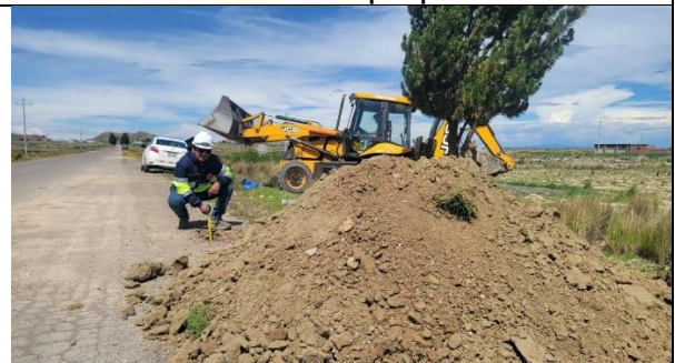
Figura 6. Colocando los conos de seguridad previniendo para posibles incidentes en zona de extracción de calicatas. Elaboración propia.
