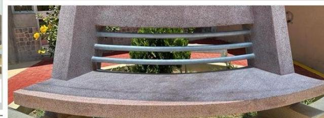
Parte de los mobiliarios de este espacio público encontramos bancas de concreto, el cual tienen mejor resistencia, durabilidad y estética. Son fabricados en concreto pulido o con acabados de granito pulido.
