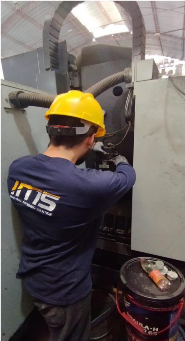
(a) Revisión del tanque de lubricación maquina Bridgeport
