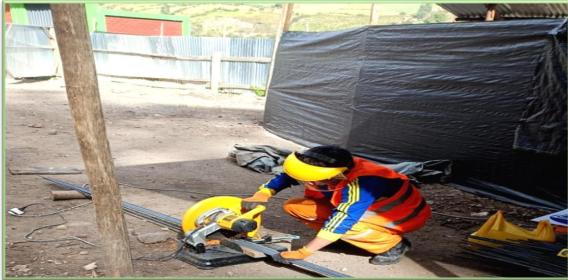
Fig. 03. En esta imagen observamos que el trabajador realiza las labores de habilitación de acero.
