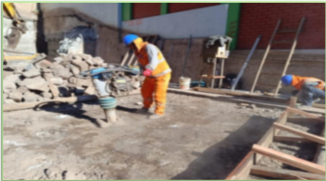
Fig. 02. Se observa los trabajos de compactación.
