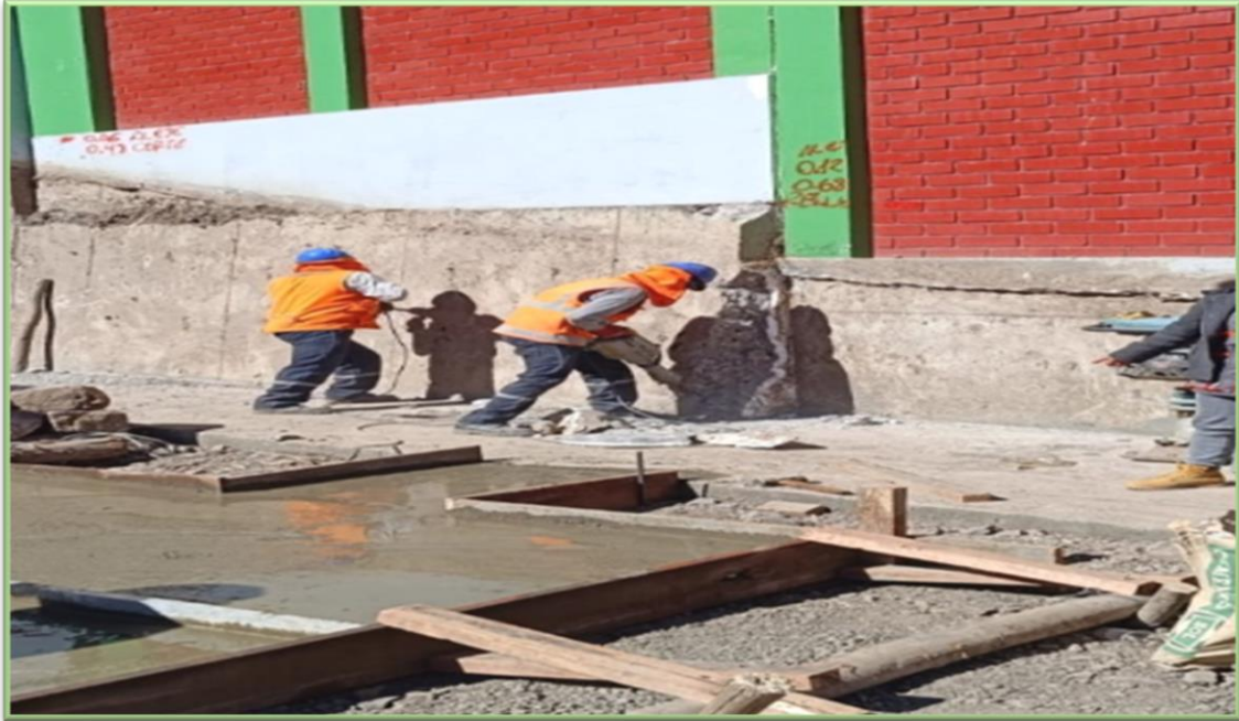
Fig. 01. En la siguiente imagen se observa trabajos de demolición manual.
