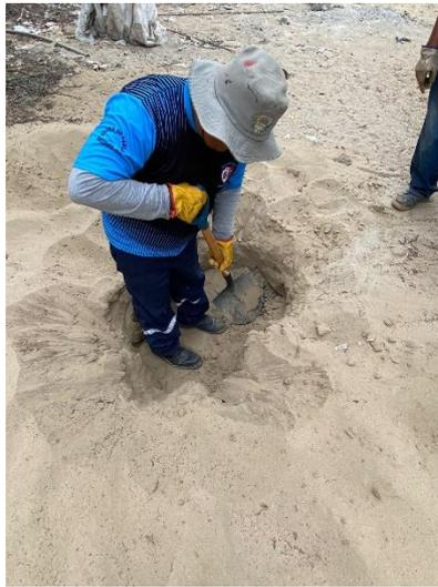
*Figura 20. Excavación de Calicata C-1.*
