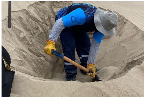
*Figura 21. Excavación de Calicata C-2*
