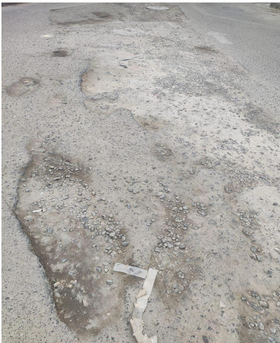
Foto 3. Pavimento rígido en mal estado en la av. Pacasmayo -S.M.P
