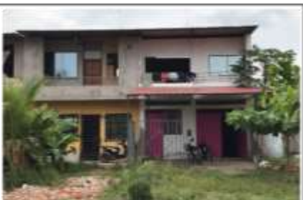
Imagen 1: Fachada de la Vivienda.
