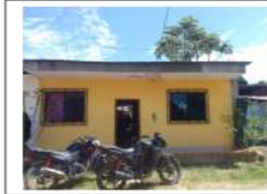
Imagen 1: Fachada de la Vivienda.
