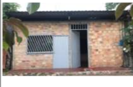
Imagen 1: Fachada de la Vivienda.
