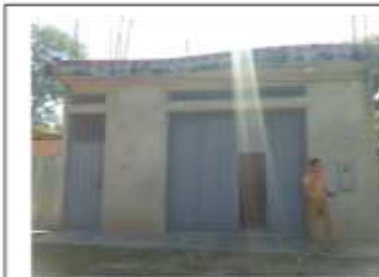
Imagen 1: Fachada de la Vivienda.
