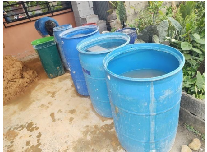
Figura 28: tiempo de curado del concreto a los 14 días
