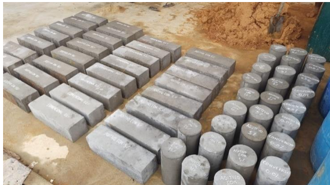
Figura 21: viguetas y probetas terminadas
