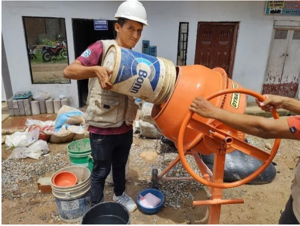
Figura 9: mezcla de agregado para viguetas
