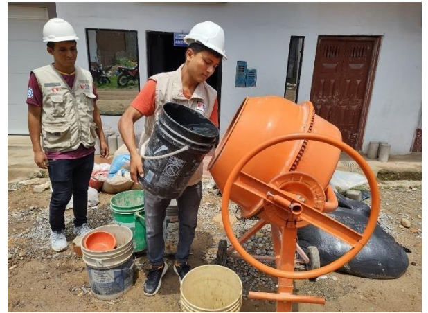
Figura 10: mezcla de agregado para probetas
