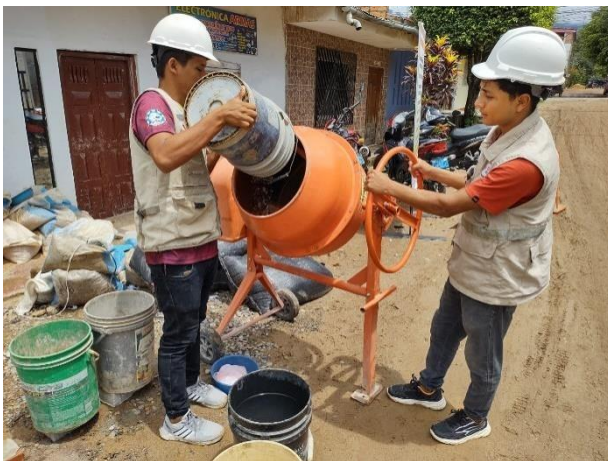
Figura 7: Dosificación de mezcla
