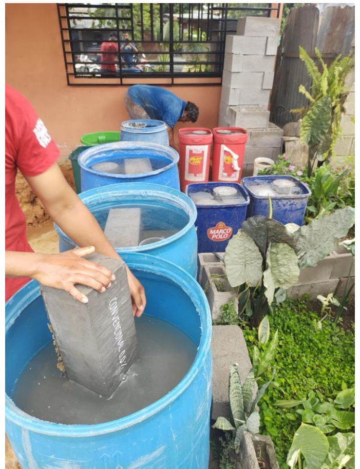
Figura 30: final del tiempo de curado del concreto
