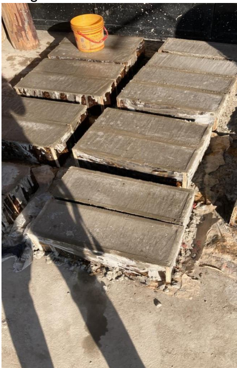
Figura 15: vigas luego de 11 horas fraguando
