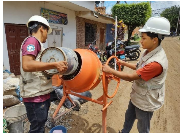
Figura 8: inicio de elaboración de vigas y probetas
