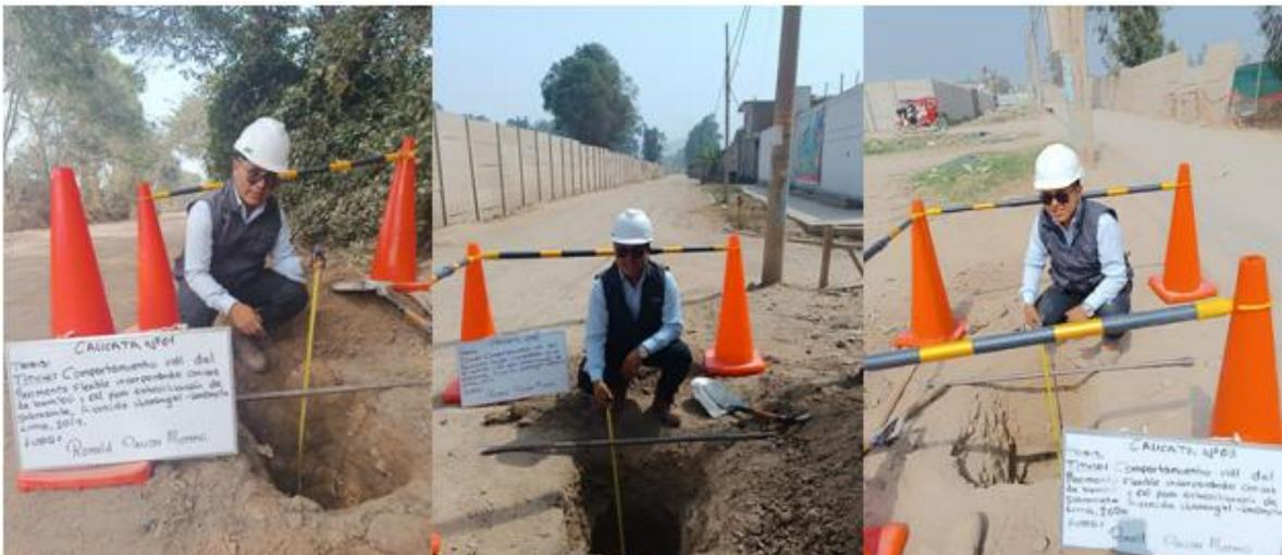
**Figura 6.** Pozo de extracción de muestras de suelo.
