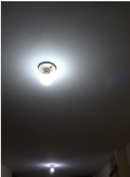
Figura N° 31. Evidencia de la infraestructura y la iluminación
