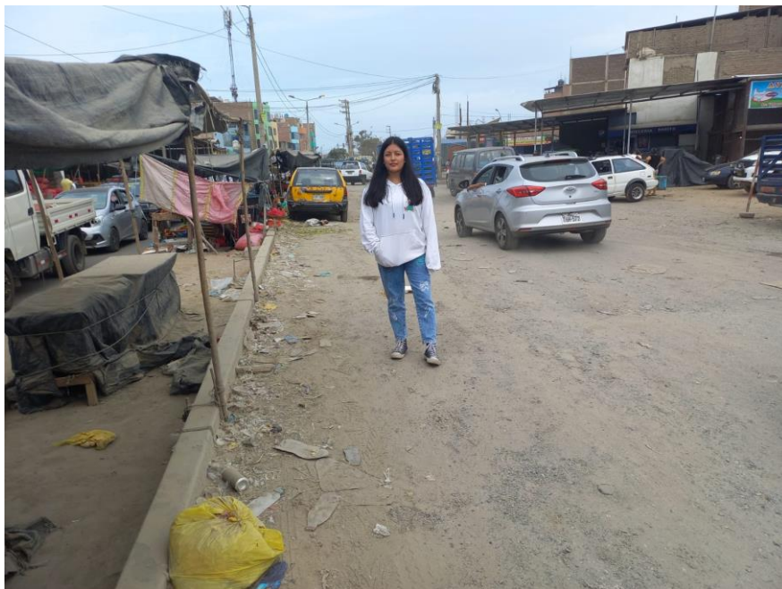
Figura 18: Estado actual de las pistas frente al mercado. (Av. Federico Villarreal)
