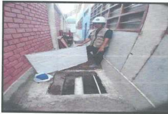
FOTO N° 01: EXCAVACION DE CALICATA 01.
