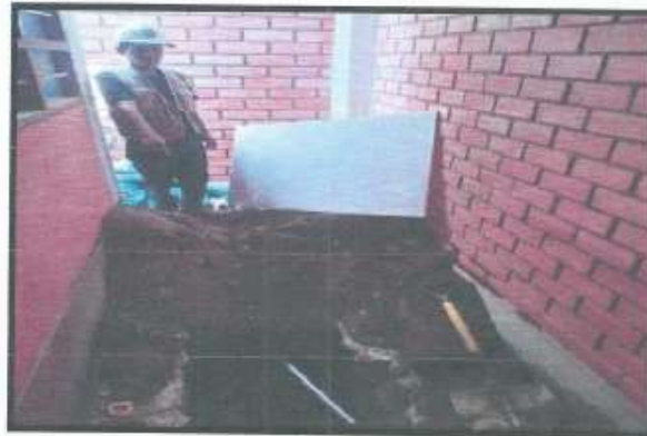
FOTO N° 02: EXCAVACION DE CALICATA 02.
