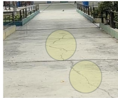
Figura: 03 estado actual de pisos
