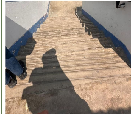
Figura: 03 Estado actual Escalera
