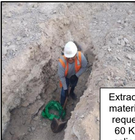
Extracción del material suelo requerido de 60 Kg de la calicata N°2
