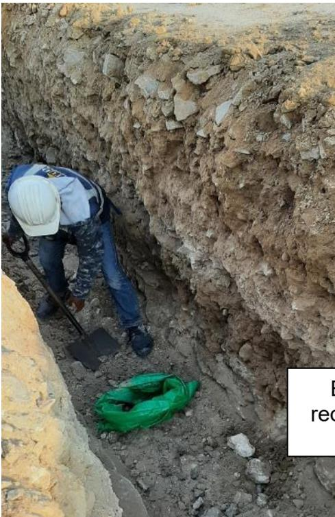
Extracción del material suelo requerido de 60 Kg de la calicata N°1
