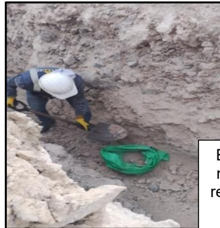
Extracción del material suelo requerido de 60 Kg de la calicata N°3
