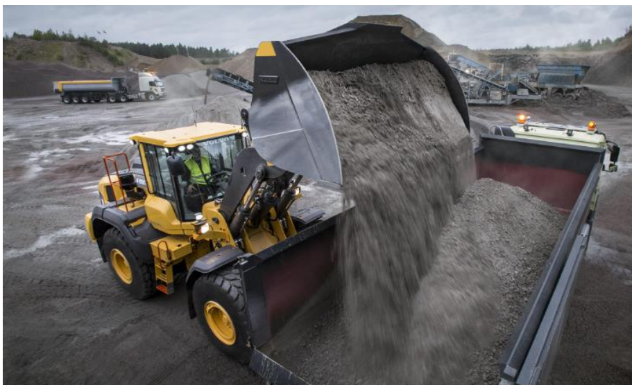
Figura 10. Operación de llenado de volquete, utilizando LOAD ASSIST.
