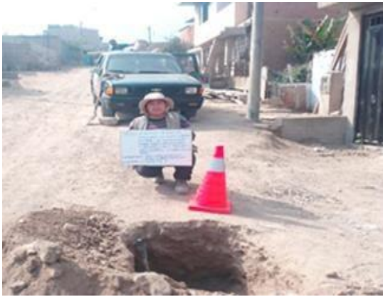
Foto: Calicata 2 con una profundidad de 1.50 m de 1.00 x 1.00 m.
