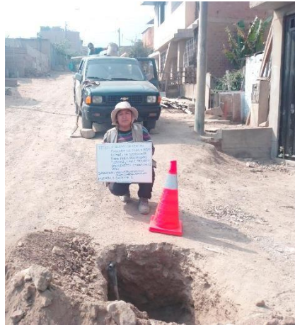
Figura 12. Calicata 2 a una profundidad de 1.50m de 1.00 x1.00
