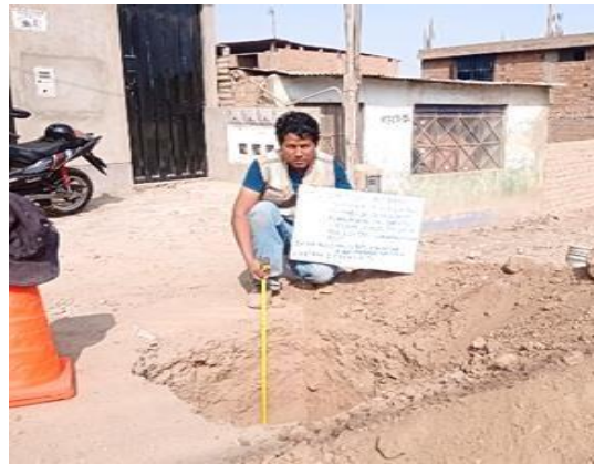
Foto: Calicata 3 con una profundidad de 1.50 m de 1.00 x 1.00 m.
