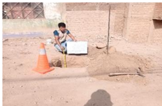
Foto: Calicata 1 con una profundidad de 1.50 m de 1.00 x 1.00 m.
