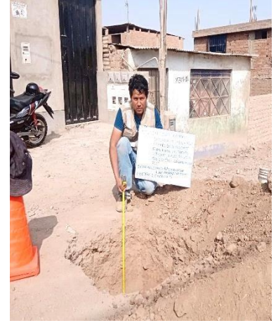
Figura 11. Calicata 3 a una profundidad de 1.50m de 1.00 x1.00
