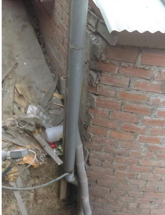
*Figura 12.* Tubo de 4" desagüe en acceso a la vivienda.
