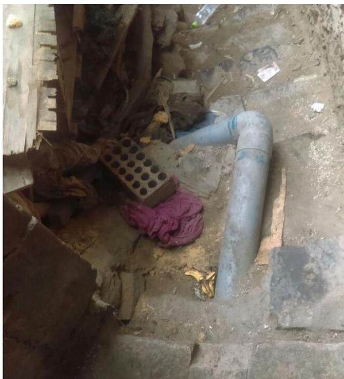
*Figura 8.* Tubo de 4" desagüe en acceso a la vivienda.
