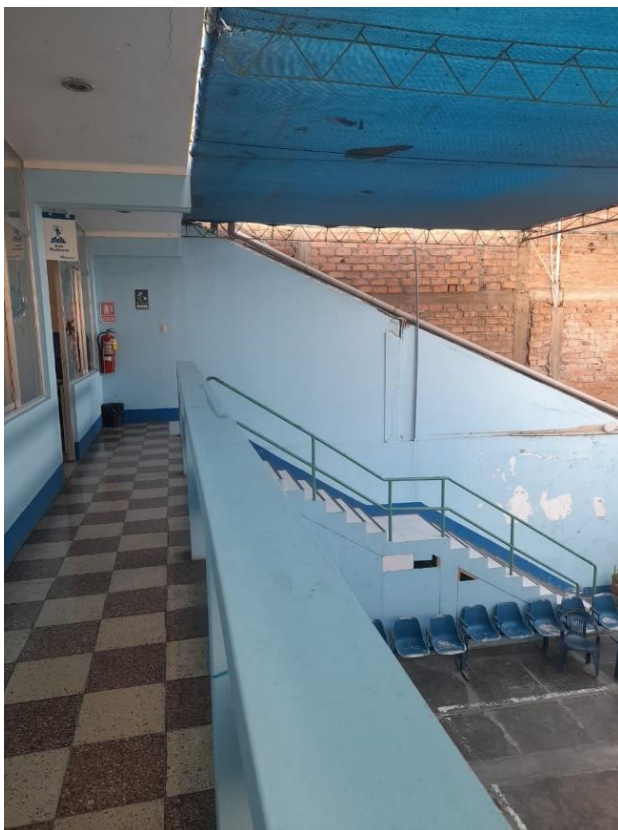
Figura 8. Acceso al segundo nivel en el CAM EsSalud Chimbote.
