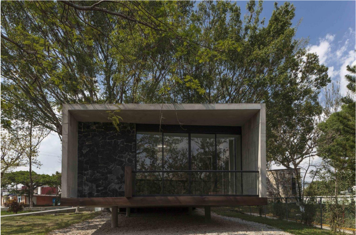
Figura 41: Fachada secundaria de la Casa del Abuelo en Córdoba, Veracruz
