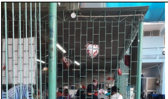
Figura 3: Muro divisorio de acero con trama de reja en el CAM EsSalud
