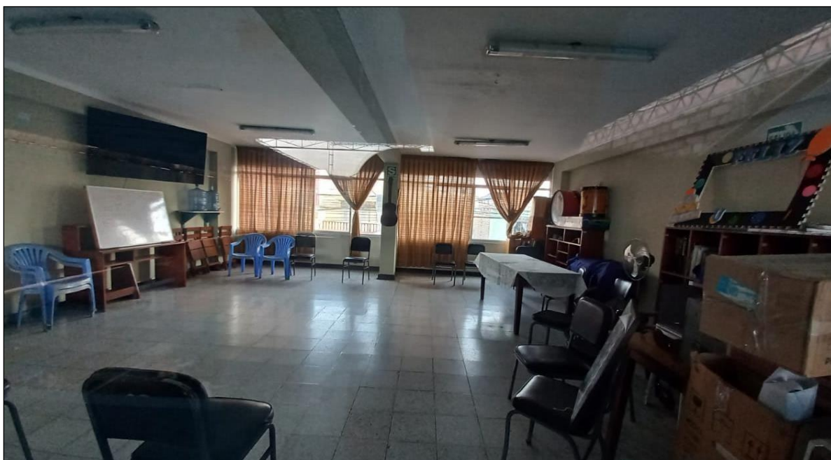
Figura 12: Estado actual del salón multiusos en el CAM-EsSalud
