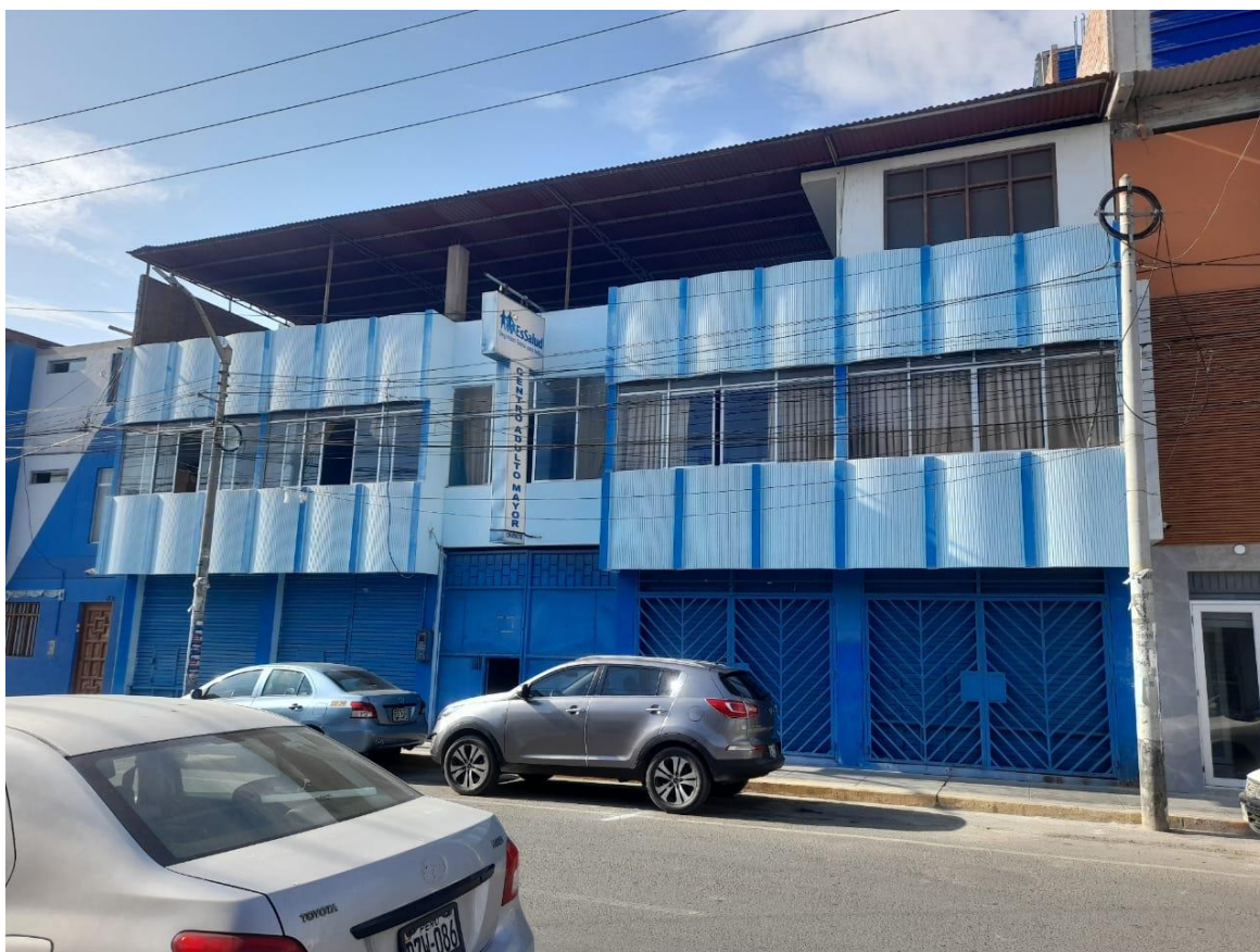
Figura 5. Exteriores del CAM EsSalud Chimbote
