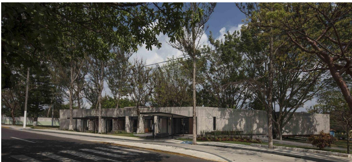
Figura 40: Fachada principal de la Casa del Abuelo en Córdoba, Veracruz.
