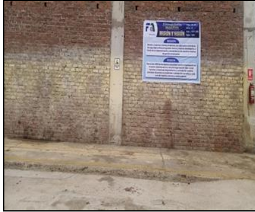
Figura 11 Situación del área de soldeo libre de residuos.
