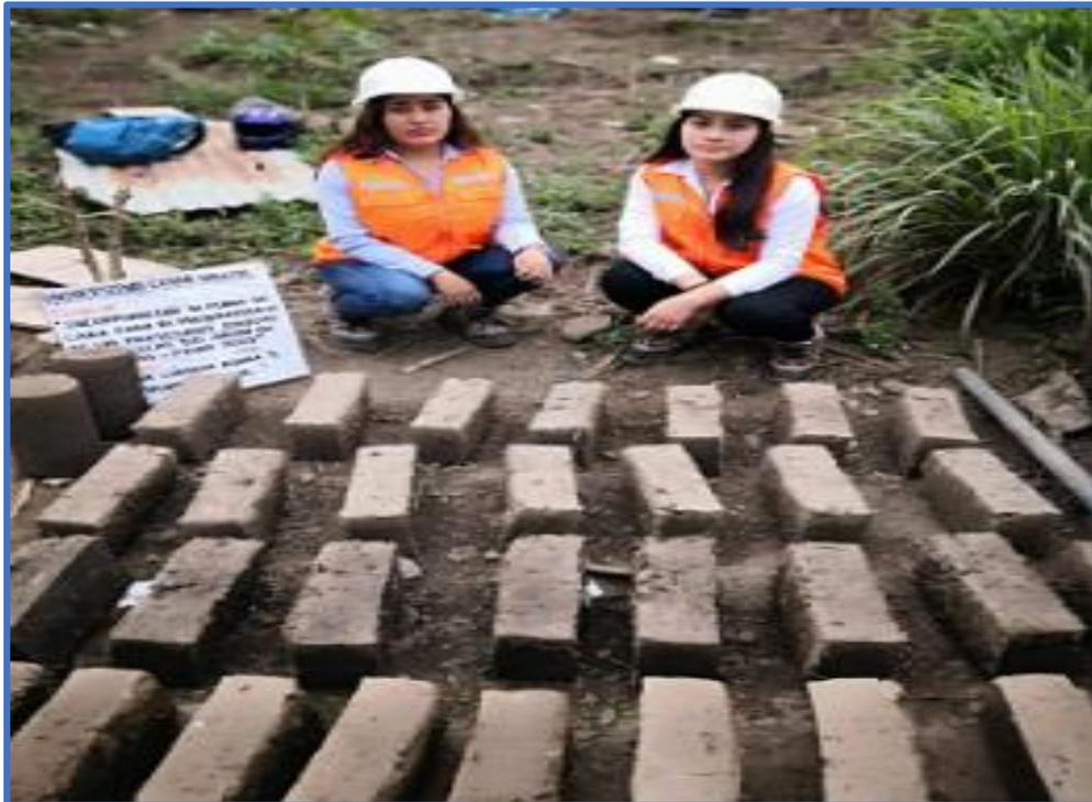
Figura N°18: Adobe en proceso de secado.
