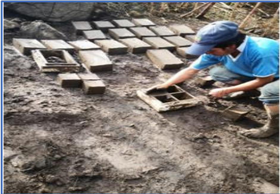
**Figura N°16:** Fabricación de bloques de adobe
