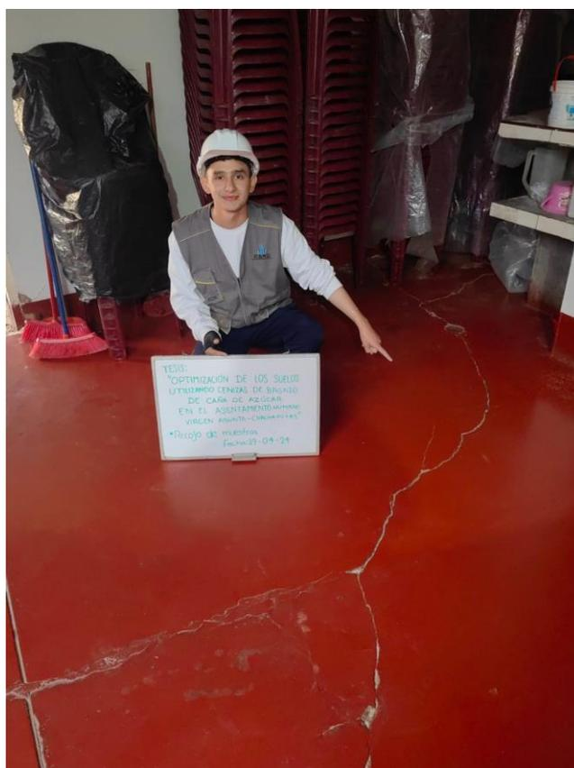
Figura 31. Hundimientos y fracturas en las viviendas de la zona
