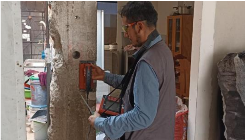
Figura 3. Escaneo de refuerzos
