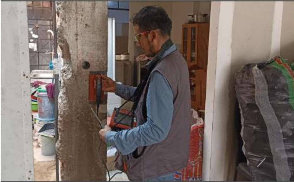
Personal Encargado realizando Escaneo de Columna
