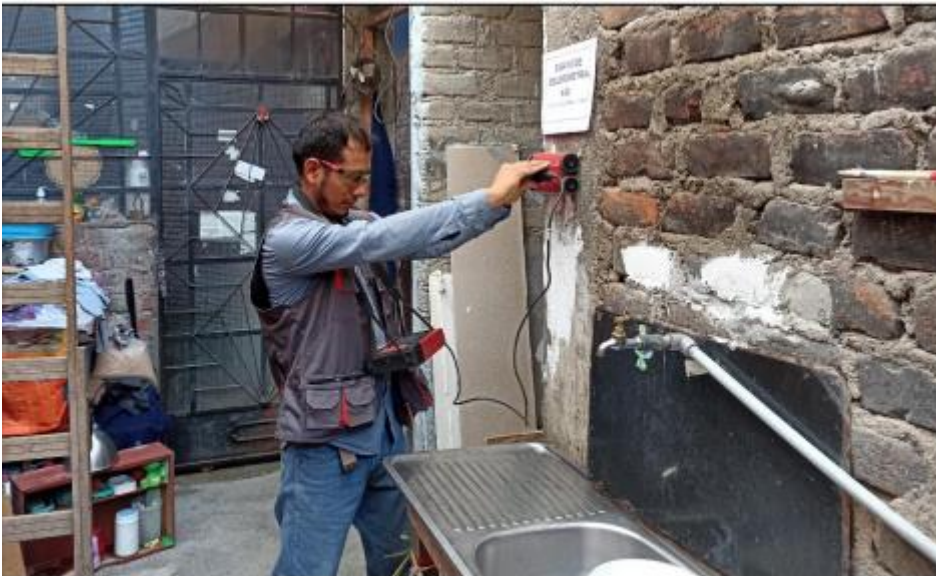
Personal Encargado realizando Escaneo de Columna
