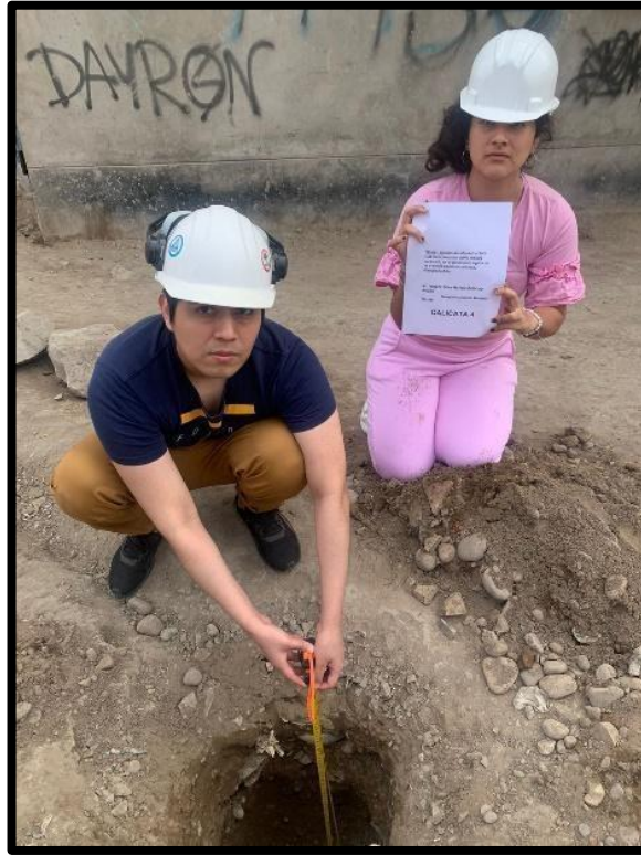
Figura 4: Ubicación de la calicata N° 4
