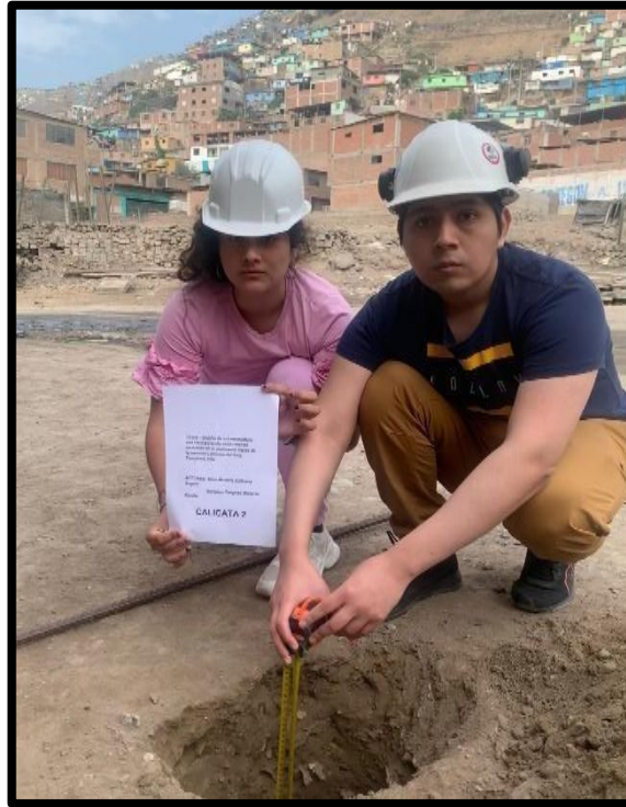
Figura 2. Ubicación de la calicata N° 2
