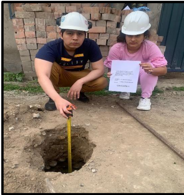
Figura 1. Ubicación de la calicata N° 1.
