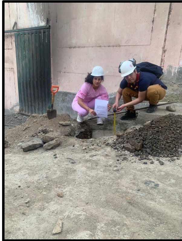
Figura 5: Ubicación de la calicata N° 5
