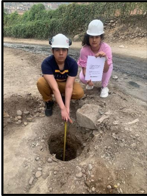
Figura 3: Ubicación de la calicata N° 3
