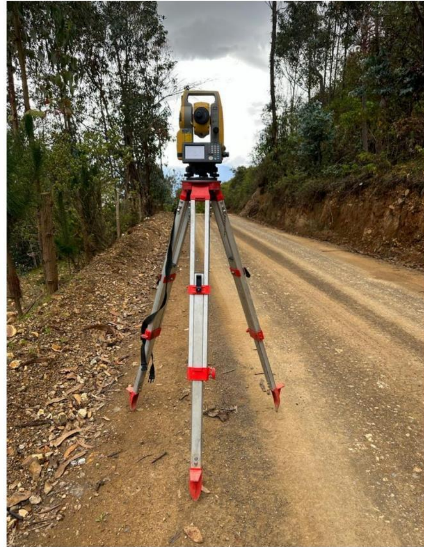
EQUIPOS UTILIZADOS – ESTACION TOTAL
