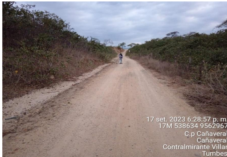
Fotografía 01: El estado actual del tramo existente que comunica los caseríos el Palmo- Cardalitos, en la provincia de Contralmirante Villar, en el distrito de Casitas necesita
