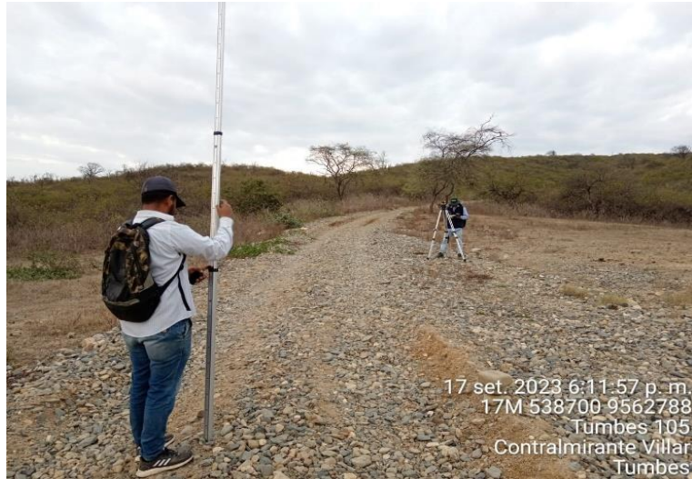
Fotografía 03: En la foto se muestra al prismo dando los puntos de borde de la trocha carrozable al topógrafo.
