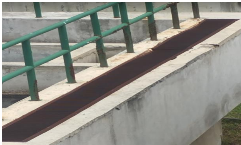
Figura 6 Imagen de cámara de rejas
