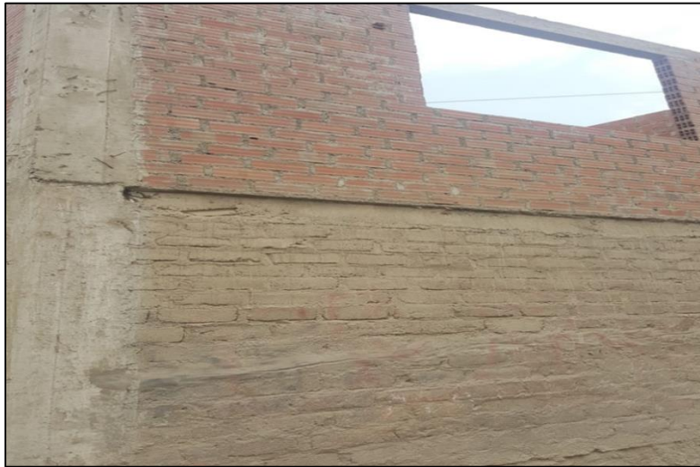
Figura 1: Vivienda autoconstruida presenta dos unidades de albañilería
