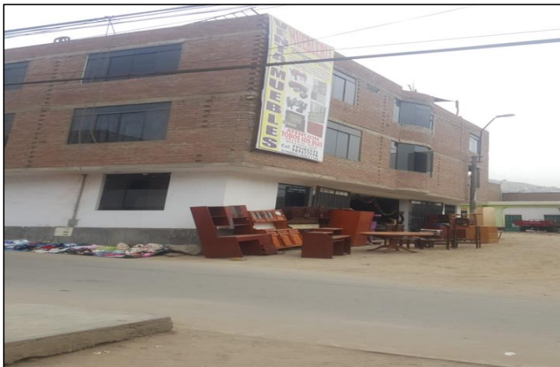
Fuente: Toma fotográfica propia
