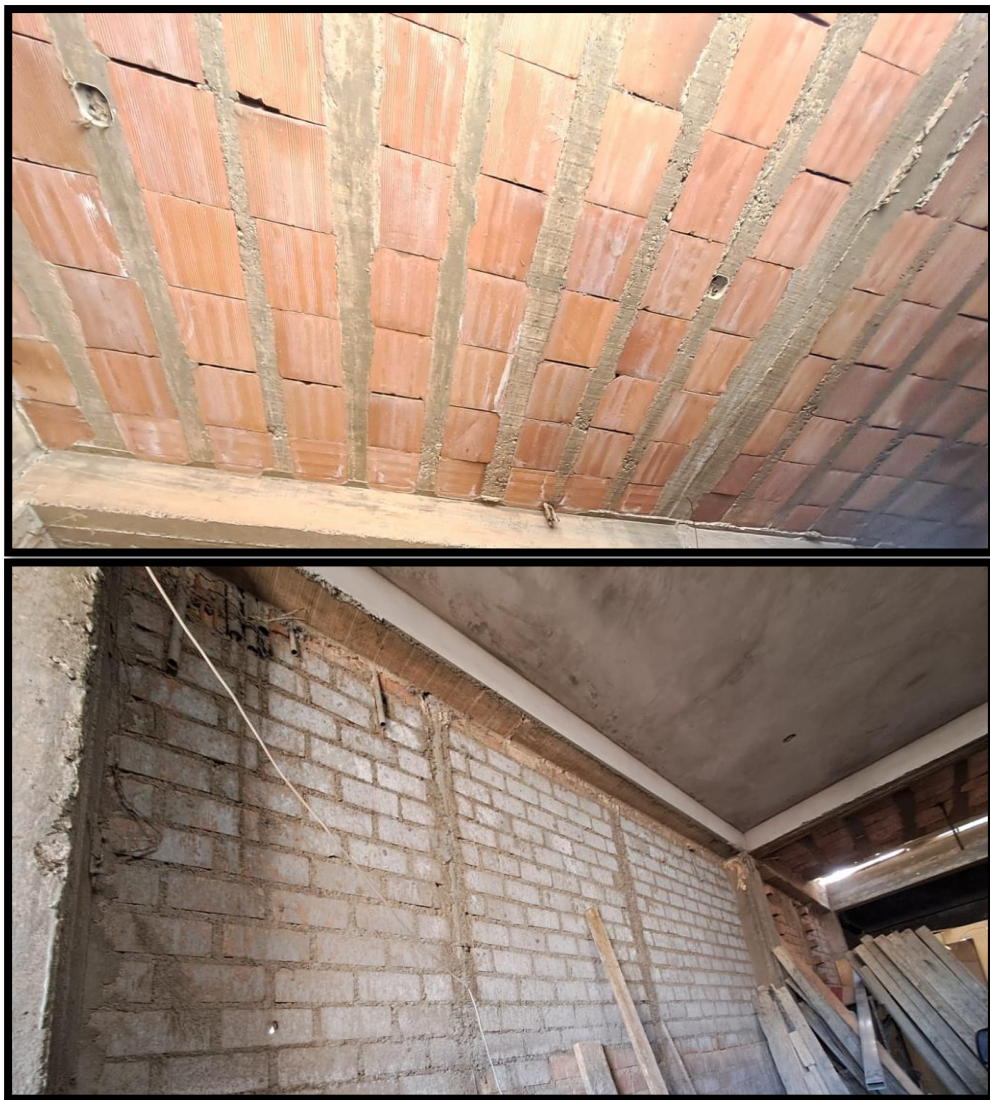
Figura 23. Viguetas con distancias pequeñas.
