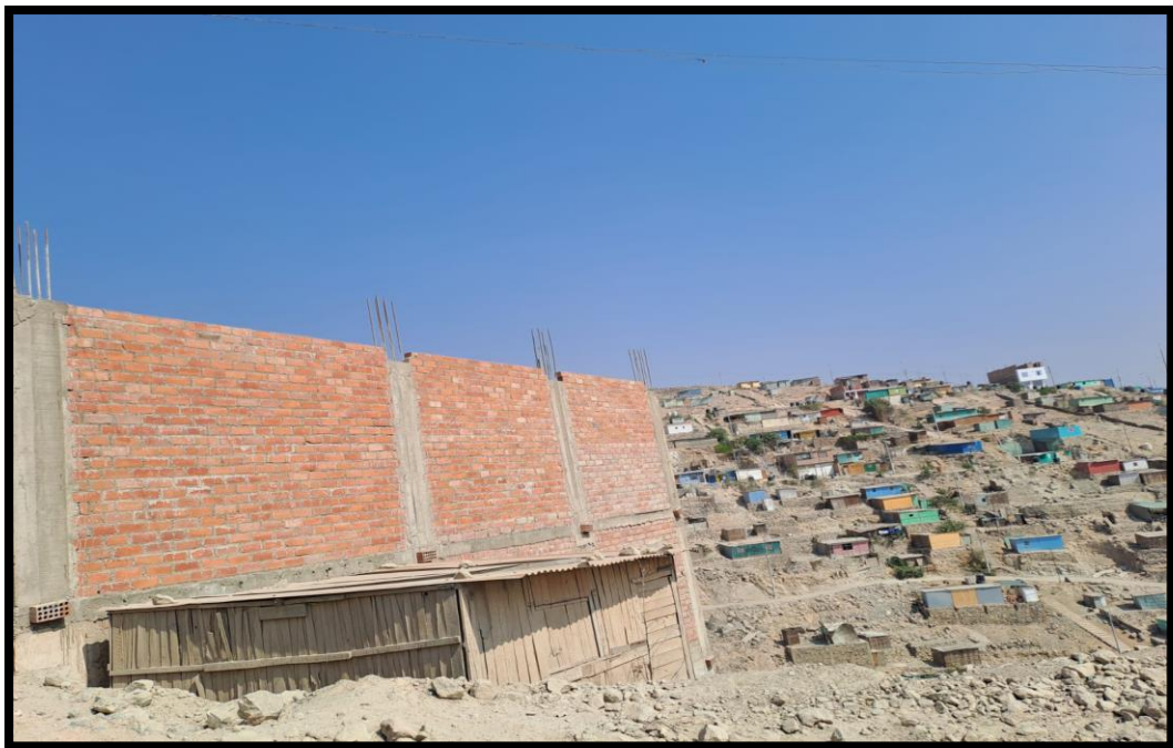
Figura 2. Viviendas autoconstruidas en el asentamiento humano Buena Vista de Manchay
