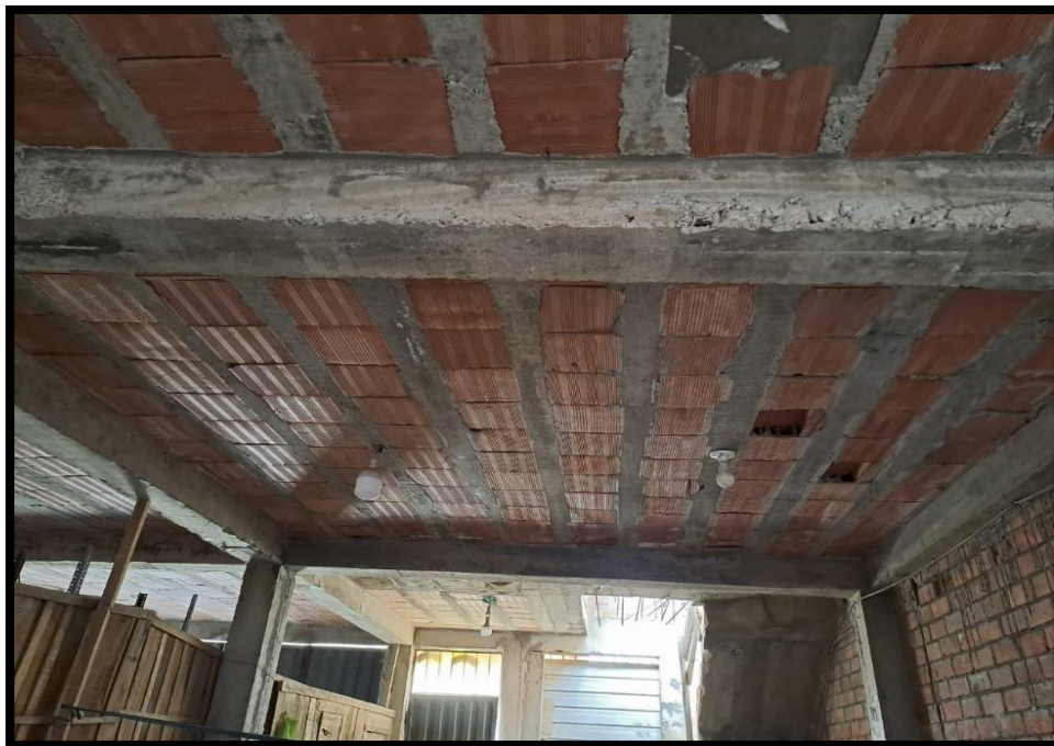
Figura 6. Presencia de cangrejas en las vigas, acero expuesto y en no cumple con el ancho de la vigueta
