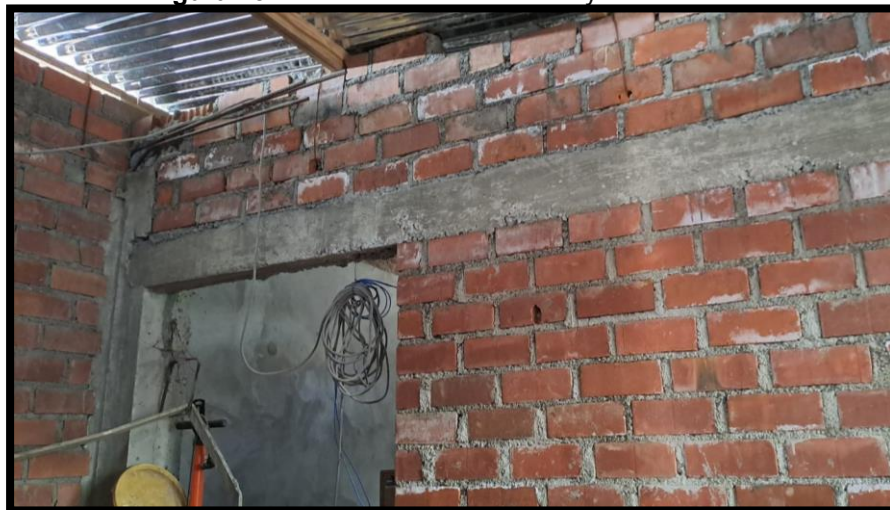
Figura 25. Distancia de morteros mayores a 2 cm.
