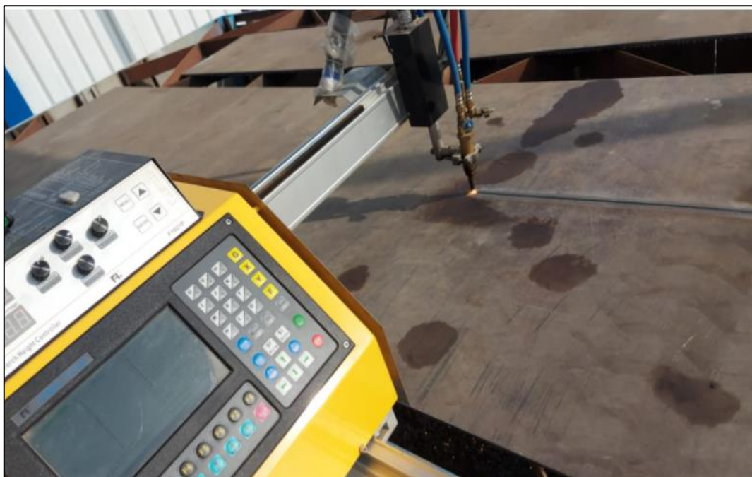
Anexo 24: Corte de planchas, ´perfiles y ángulos.
