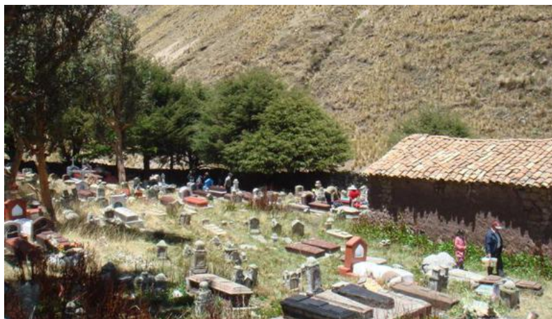
Figura 22: Cementerio en abandono en Sacsamarca, Ayacucho
