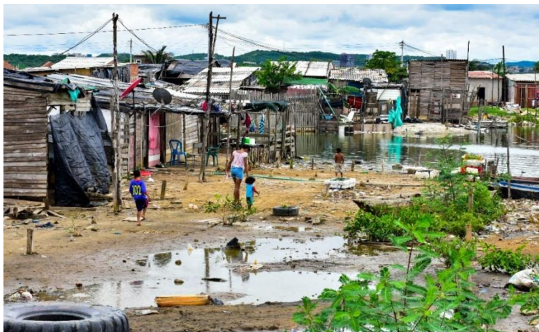
Figura 17: Asentamiento de alto riesgo en Barranquilla, Colombia
