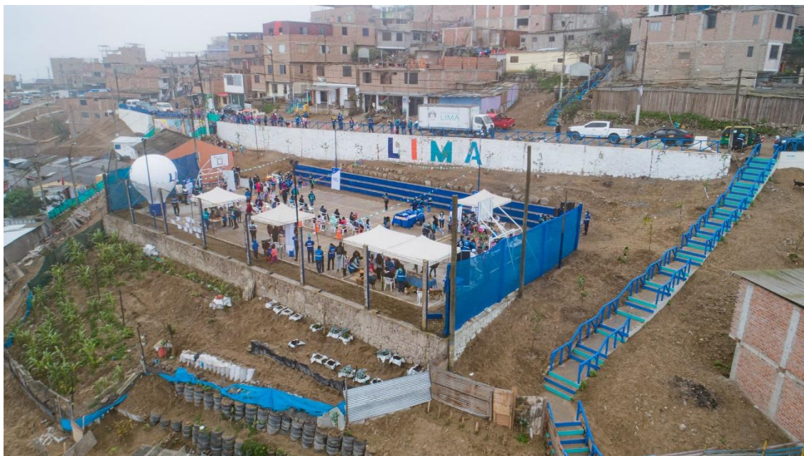
Figura 38: Vista aérea 2 de la zona de estudio (A.A.H.H. Bello horizonte)
