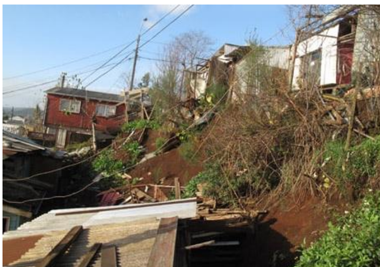
Figura 18: Derrumbes en Cerro la Pólvora
