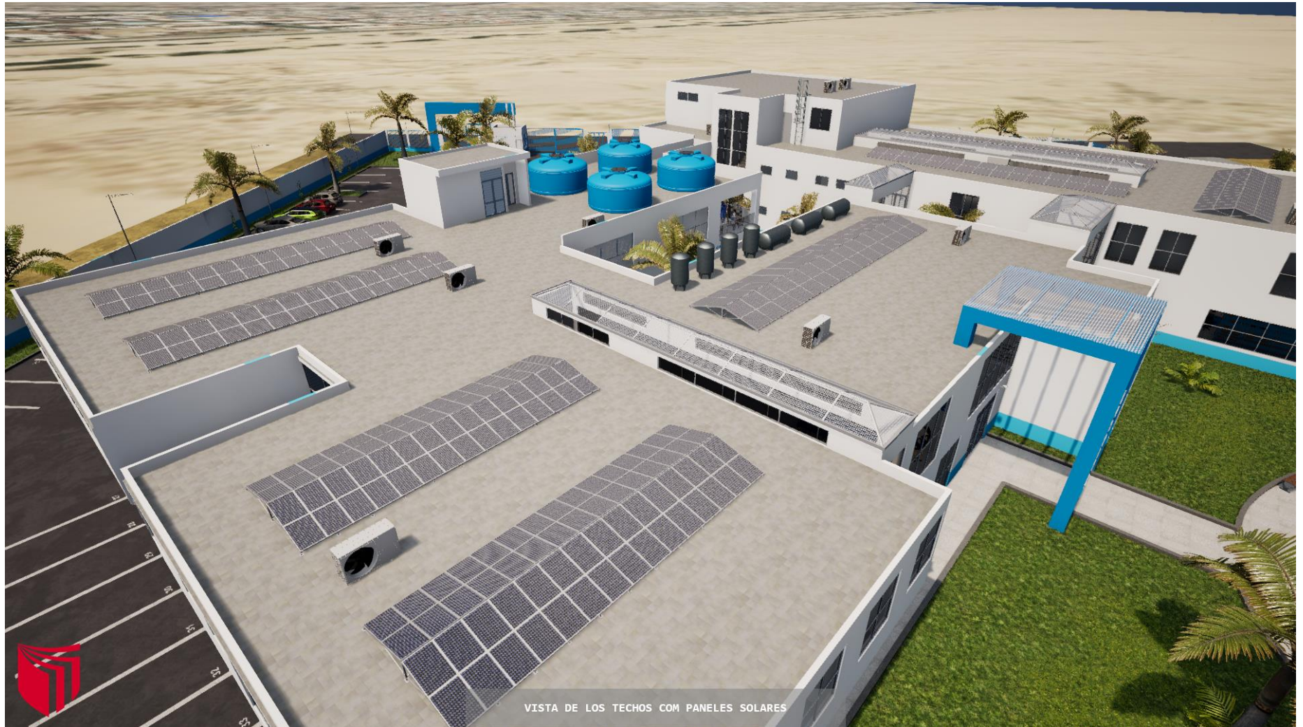
Vista de los techos con paneles solares. (fuente: propia)
