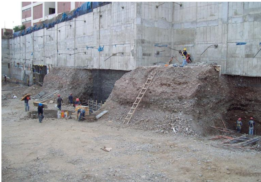
Figura 20. Muros Anclados Pabellón R universidad de Lima 2008
