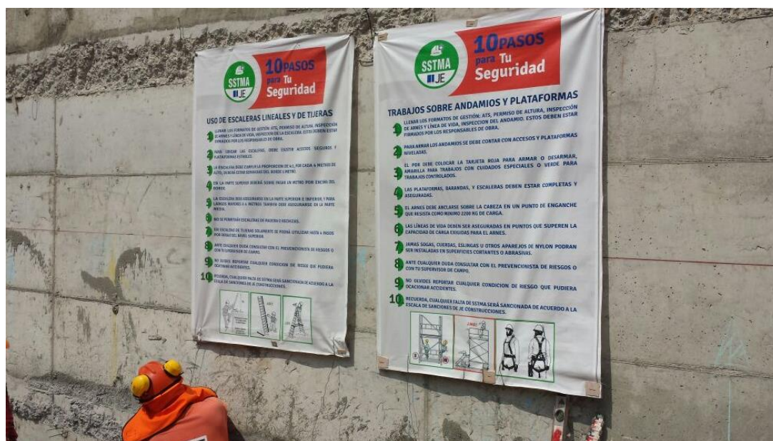
Figura 16. Instalación de banners de obra sobre los muros anclados.
