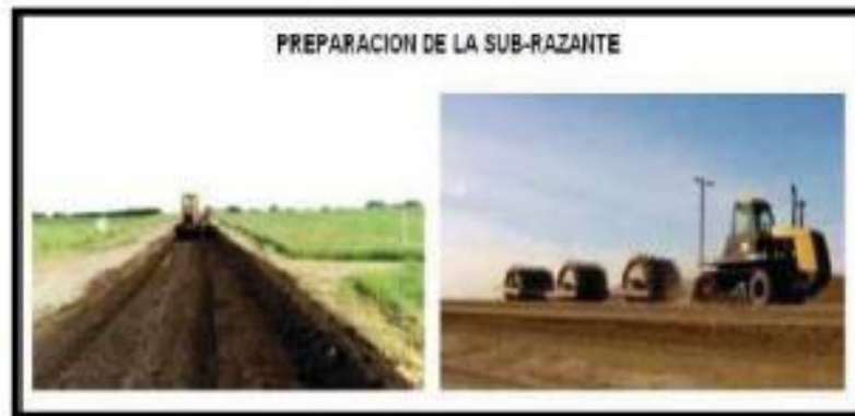
Fases para estructuración de la sub rasante
