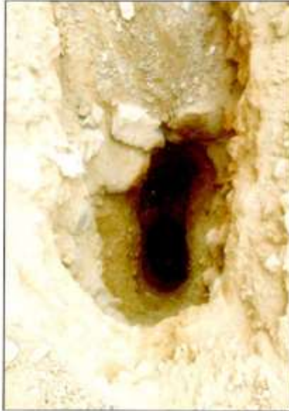
VISTA DE LA CALICATA 2
