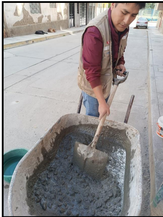
Ilustración 79. Mezcla de concreto
