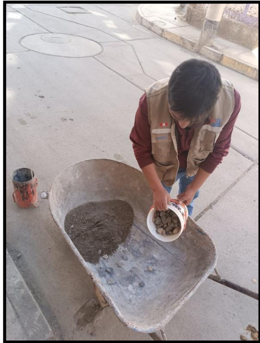
Ilustración 76. Mezcla de concreto 210kg/cm 2
