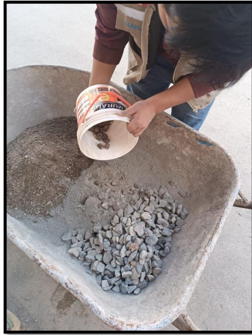
Ilustración 78. Adición de partículas de acero a la mezcla
