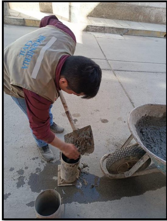
Ilustración 80. Vaciado de concreto
