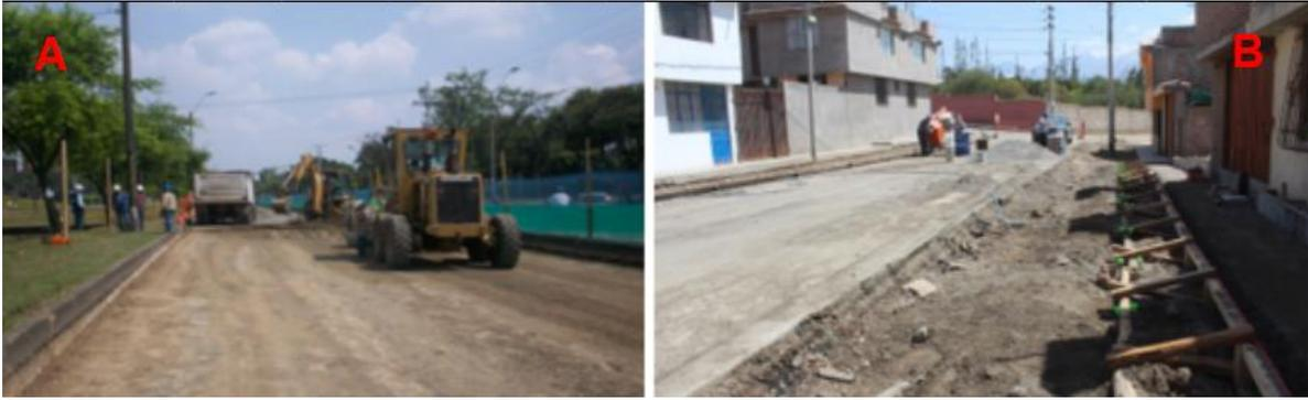
Nota: (a) Compactado y nivelado con equipo de maquinaria pesada para la conformación de la base en la ciudad de puerto Maldonado, (b) Compactado y nivelado con mano de obra para la conformación de la base en la ciudad de Puno (9).
