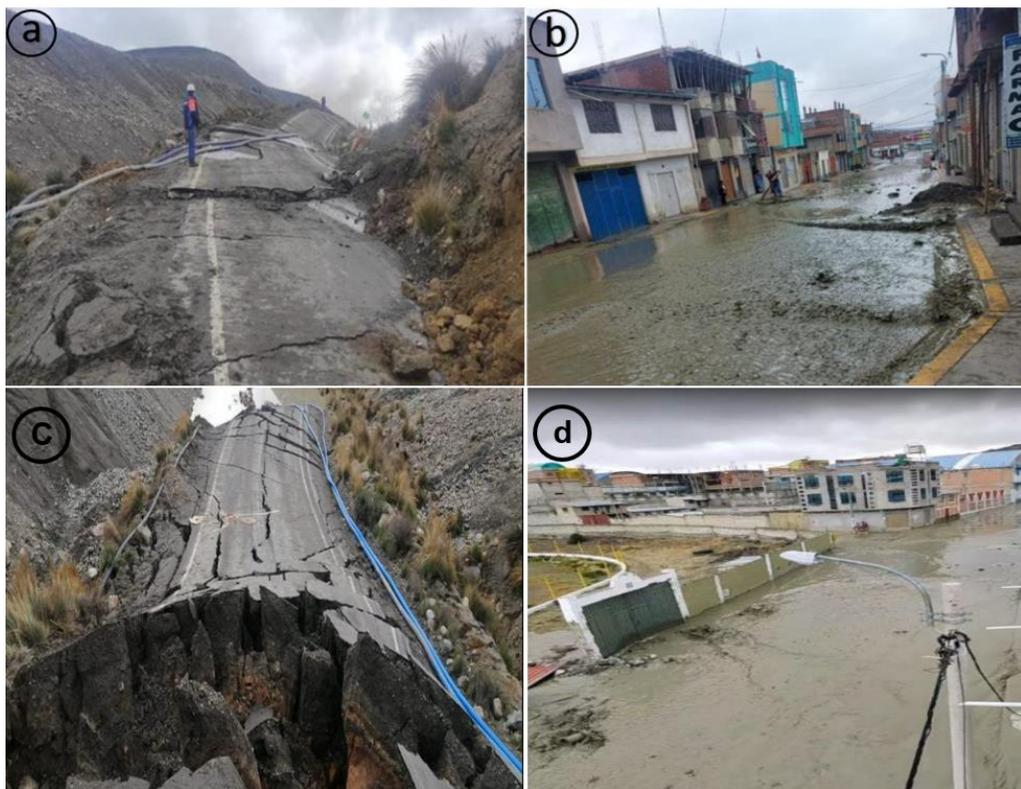
Nota: (a) y (c) Rotura y desprendimiento del asfalto, (b) y (d) Daños ocasionados en las infraestructuras y la contaminación de las calles del distrito de Ananea por colapso de depósitos de tranques Post- Operativo y Operativo (9).
