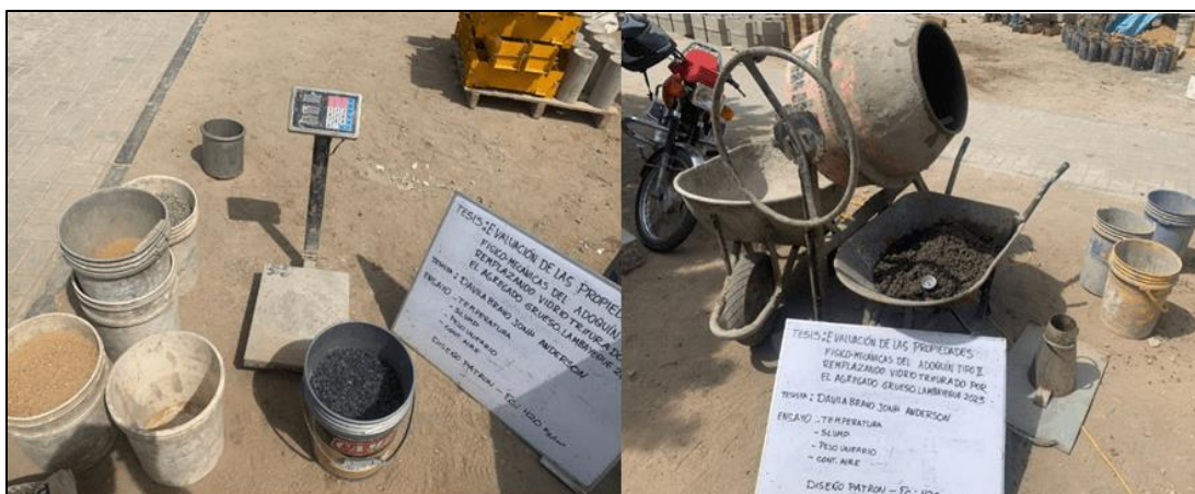
Figura 18: Proceso de preparación de la mezcla de concreto para elaboración de los adoquines.2023.
