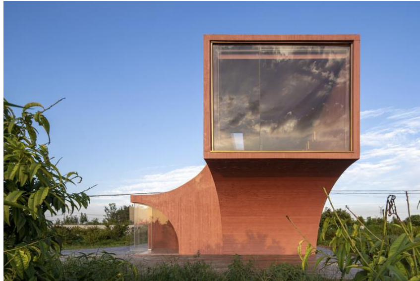
Figura N° 2: Vista del centro comunitario Jiazuo – Cabaña del melocotón
