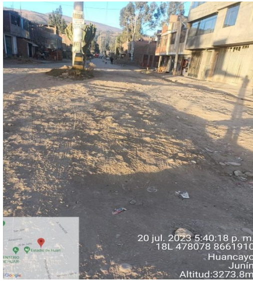
Figura 1. Reconocimiento de la subrasante de la Avenida 31 de Octubre
