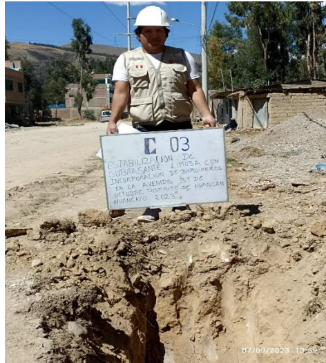
Figura 5. Calicata 3 con 1.5m de profundidad en la Avenida 31 de octubre.
