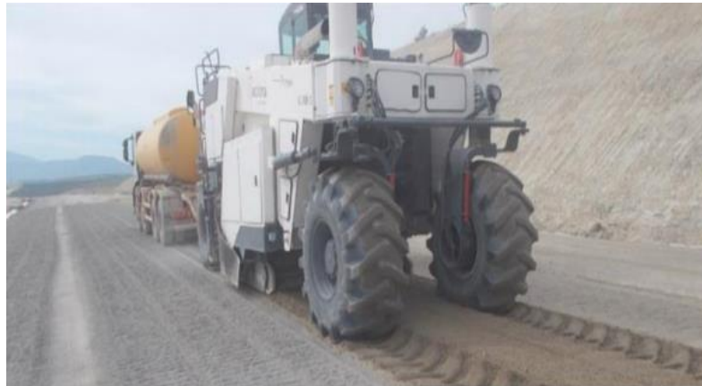
Figura N°1. La estabilización del terreno utilizando productos químicos.
