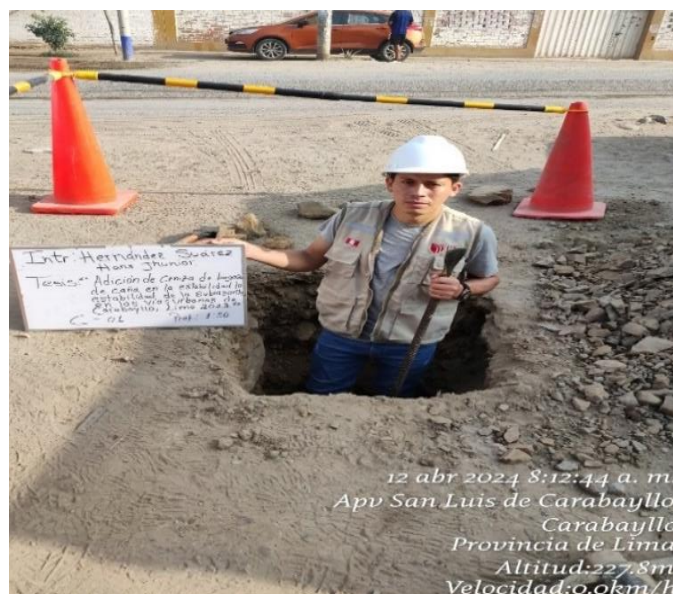
Imagen 5. Excavación de calicata N°01.
