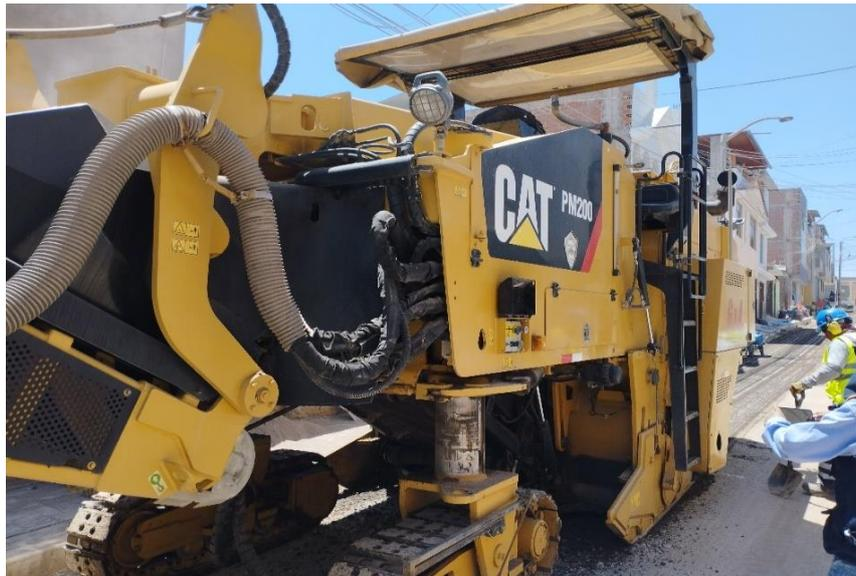
**Figura 10.** *Extracción del material con givas giratorias*
