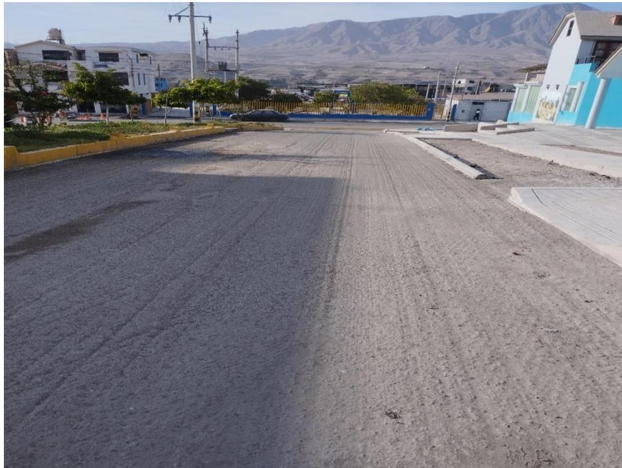
**Figura 8.** Estado actual de la carpeta asfáltica
