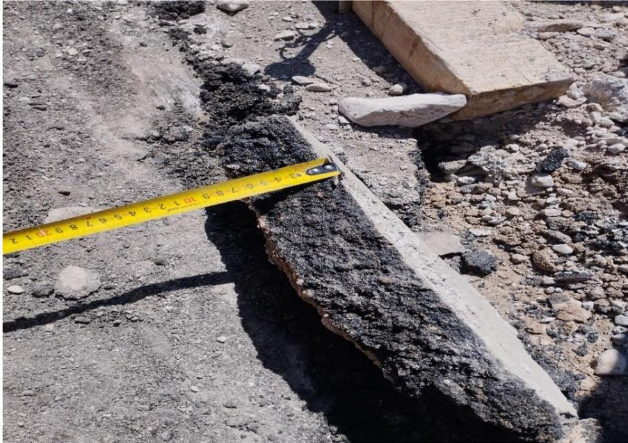
**Figura 12.** *Extracción de 6 cm de carpeta asfáltica*
