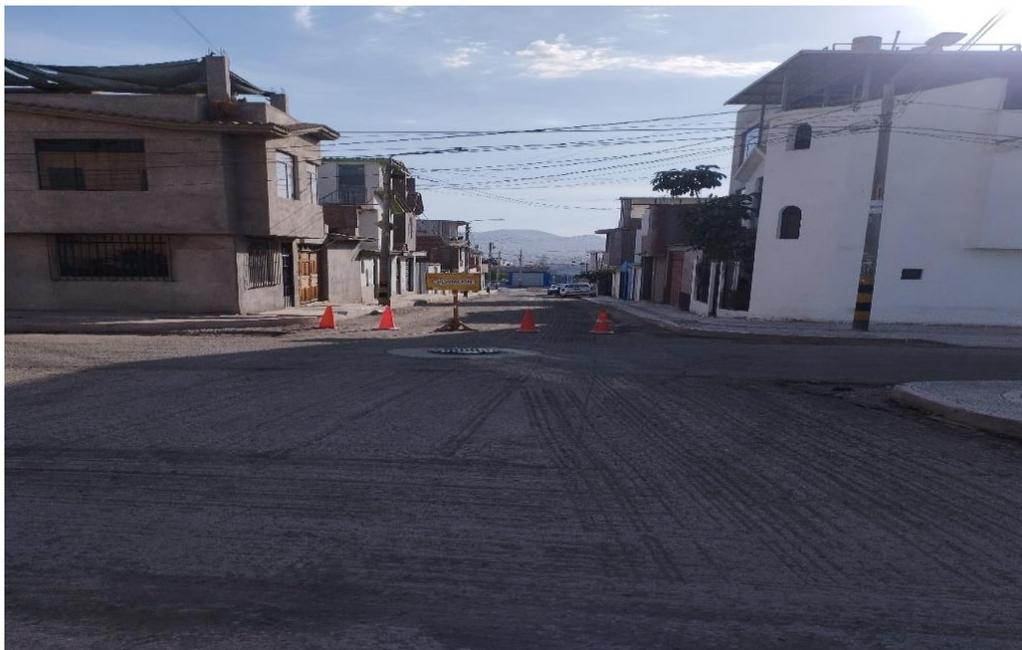
**Figura 6.** *Estado actual de la carpeta asfáltica*
