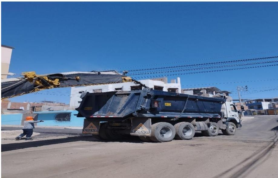
**Figura 13.** *Colocación del material en el camión*
