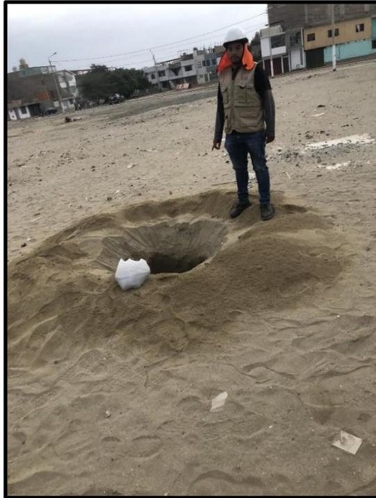
**Ilustración 10:** Excavación de la calicata "C5"
