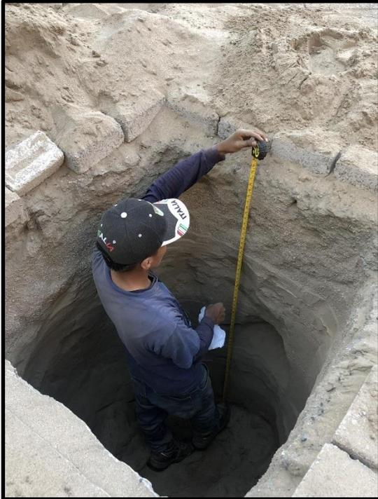
**Ilustración 2:** Trazo para la excavación de la calicata "C1"
