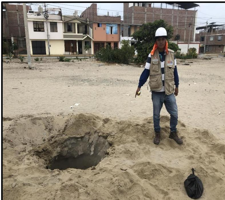
**Ilustración 9:** Excavación de la calicata "C4"
