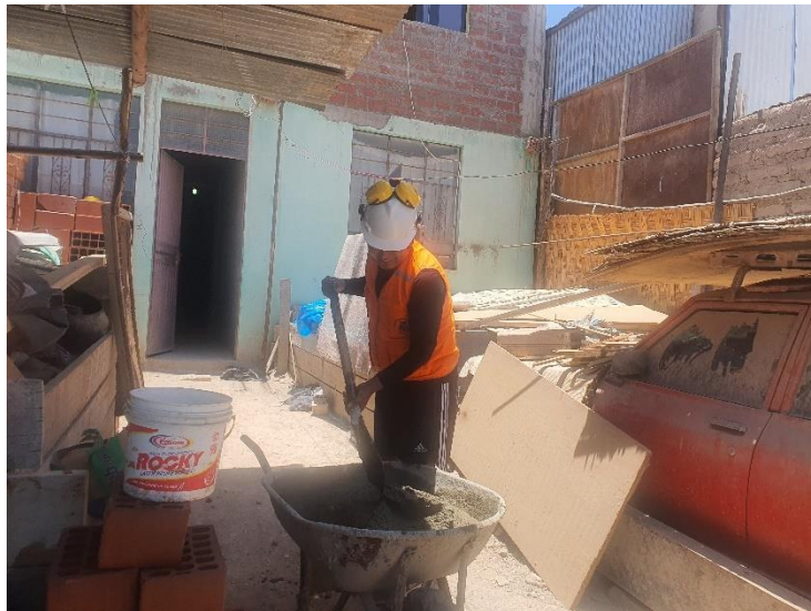
Figúra 16. Preparación del mortero.
