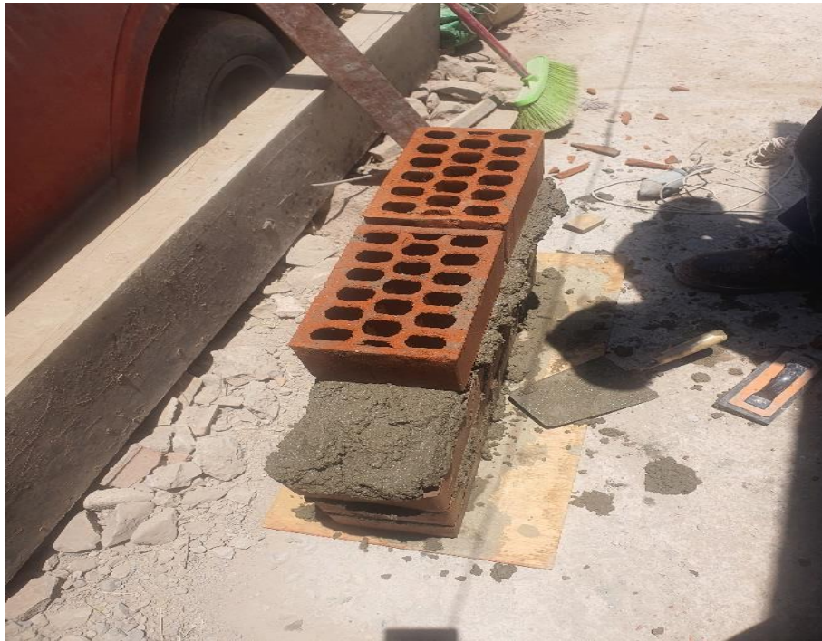
Figúra 25. Asentado de murete con ladrillo artesanal
