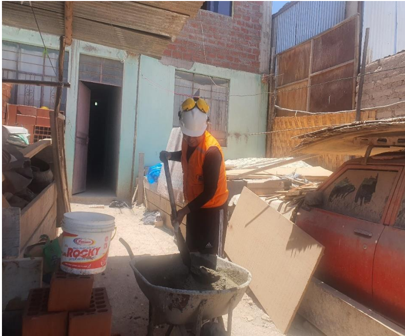
Figúra 23. Preparación de mezcla para asentado de ladrillo
