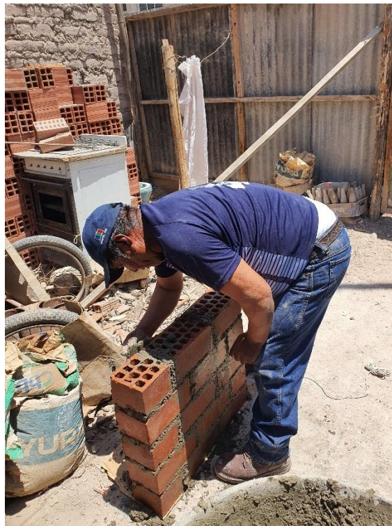
Figúra 18. Asentado de murete de albañilería
