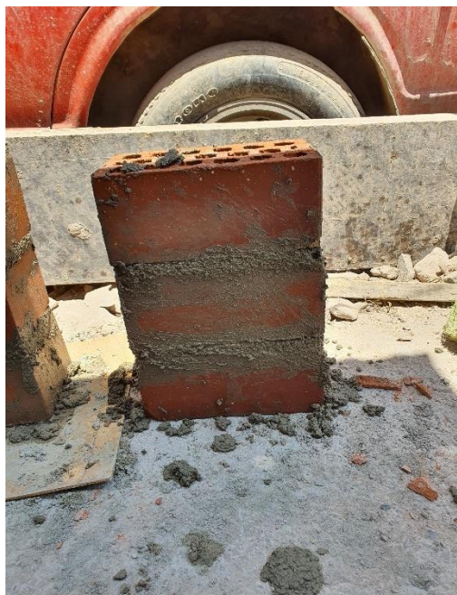
Figúra 17. Asentado de pila de albañilería
