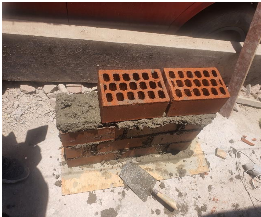
Figúra 22. Asentado de murete para ensayo de compresión diagonal de murete
